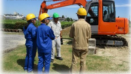
小型車両系建設機械 運転業務講習の様子
