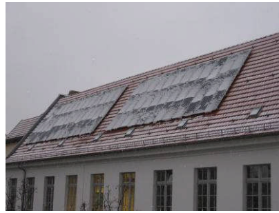
設置されたソーラーパネル
